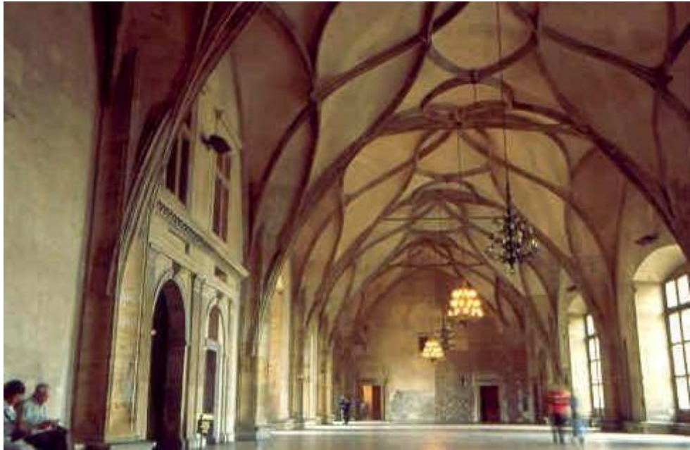
الشكل ٨-٦٠: الضلوع المزدوجة الانحناء (صالة فالد سلاف Valdislav في قلعة براغ)
