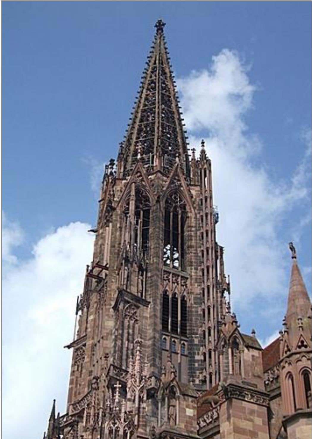
الشكل ٨-٥٦: برج كنيسة دير في فرايبورغ Freiburg
