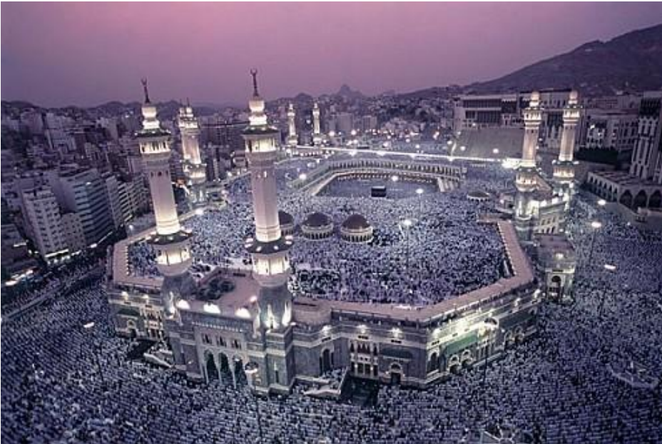
الشكل ١٦-٦: المسجد الحرام
