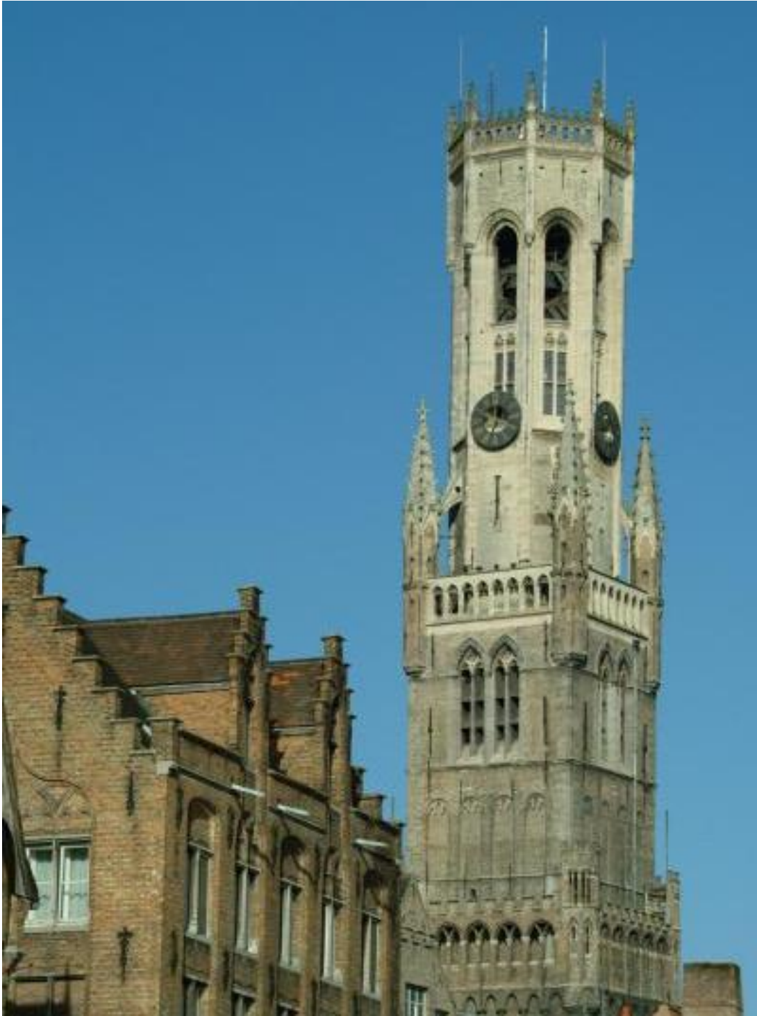
الشكل ٨-٧٩: Cloth Hall في بروكس Bruges البرج
