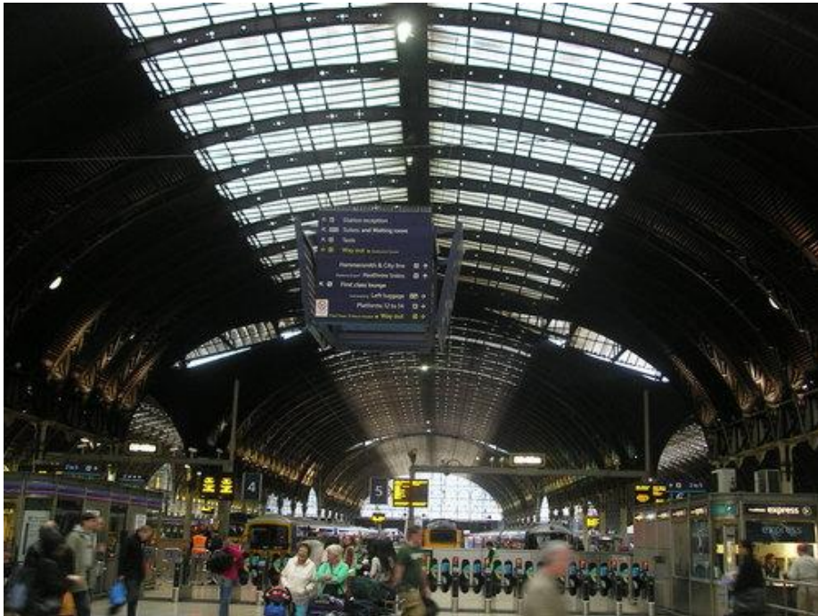
الشكل ١١-٧: سقائف القطار في محطة بادنكوتن Paddington للسكك الحديدية في لندن
