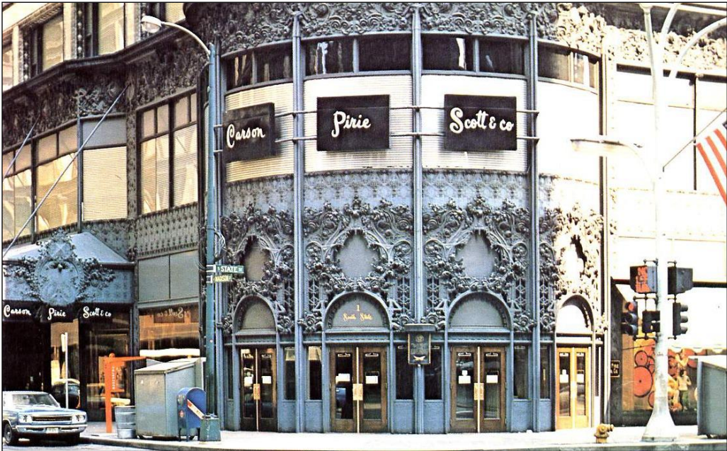
الشكل ١٢-١٧: مقصورة مدخل متجر كارسون بيرى سكوت Carson Pirie Scott
